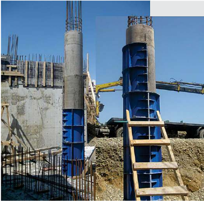
სვეტის ძრვანალი ყალიბი / ROUND COLUMN FORM WORK (MOLD)
